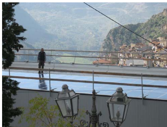
Figura 15. I lavori per la solarizzazione di uno dei 5 edifici comunali di Castronovo di Sicilia, condotti a fine 2010.
