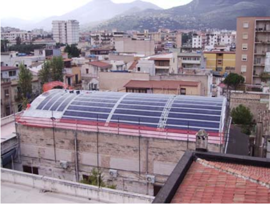
Figura 6. Per completare l'installazione dei 54 moduli fotovoltaici flessibili in silicio amorfo su guaina in Sintofol RG e collegare l'impianto sono stati sufficienti 4 giorni. (Immagine per gentile concessione di Medielettra SpA).
