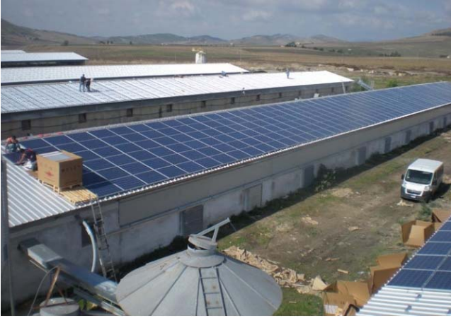
Figura 10. I lavori per la costruzione del grande impianto fotovoltaico sui tetti di 13 capannoni dell'Azienda agricola "Alizoo Terre dei Fiori" in Sicilia. (Immagine per gentile concessione di Eco's).
